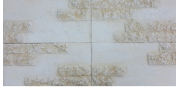
64-2 티클 엔틱판재 (4장 시공사례)
